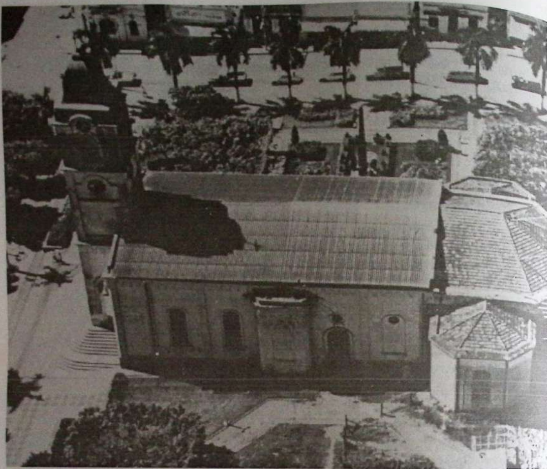
A Igreja Matriz após a reforma, em dezembro de 1952.
