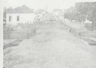
Rua 9 de junho sendo calçada.
