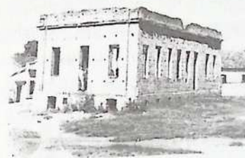
A Santa Casa, em fase de início de construção.
