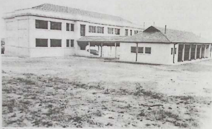
Pátio do G. E. Anita Costa visto pela parte de trás, quando o termino de sua construção.
