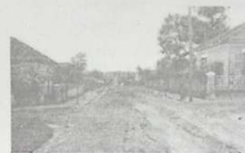
Praça Altino Arantes sendo preparada para receber calçamento.
