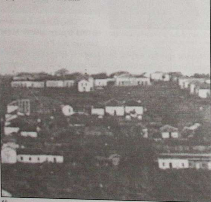
Na foto abaixo temos a primeira igreja construída na Praça da Matriz, após o incêndio que destruiu a primeira capela, ocorrido no dia 4 de agosto de 1910. Posteriormente, em 1917, foi lançada a pedra fundamental para a construção de uma nova e mais ampla Igreja Matriz de São João Batista.
