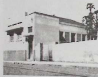
Prédio da Telesp à Rua Joaquim Miguel dos Santos.
