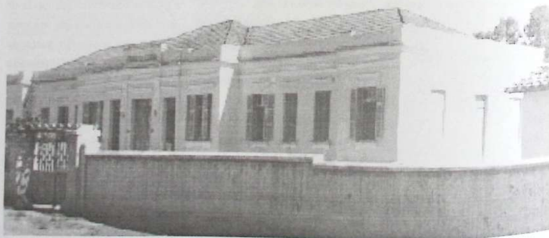
Prédio da Santa Casa, em fase de acabamento - 1936
