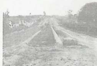
Avenida Andrade e Silva (antiga Av. Paulista) sendo construída.
