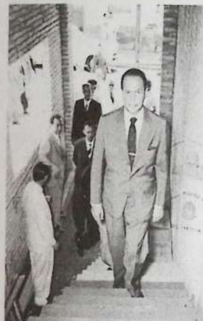
Na foto o Senador Ranieri Mazzili, visita as obras de construção da ACIO. Ao fundo, Hélio Cazarini, Akira Abe, Lêndoge Posella, Acácio Junqueira e outros.
