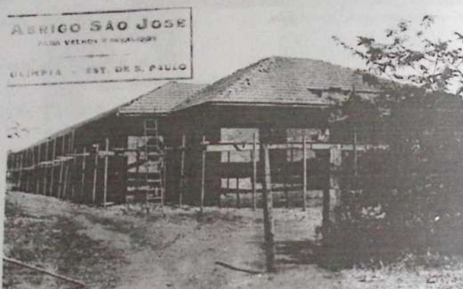
Na foto, fase de construção do novo prédio do Abrigo São José, de Olímpia.
