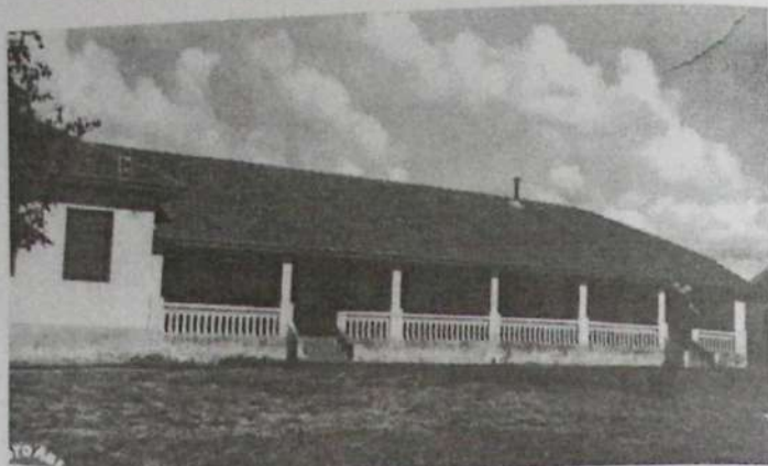
Panorama do primeiro pavilhão já terminado
