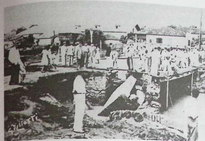
A foto registra os estragos de enchente na ponte da rua Jorge Tibiriçá, hoje David de Oliveira. Somente esta e a Ponte Preta não foram levadas pelas águas.
