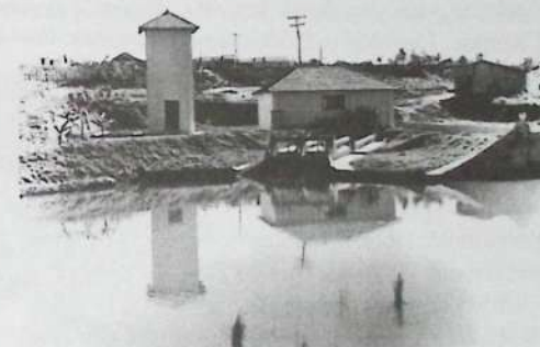
Local de captação de água, no Córrego Olhos D'Água, de onde as bombas lançam a água para o tratamento.
