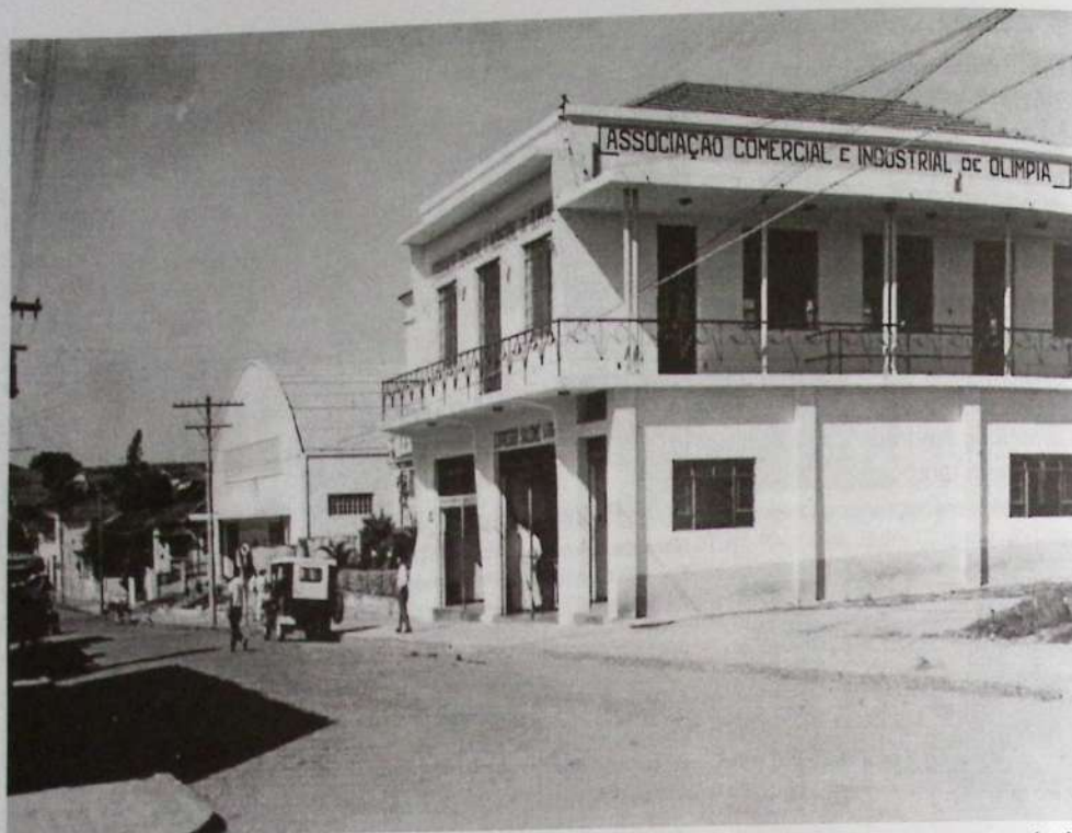
Prédio da Associação Comercial e Industrial de Olímpia (ACIO). Na parte de cima, com salão de reuniões e sala de administração; embaixo, salas de escritório e, ao fundo, salão de festas e campo para jogo de bocha.
