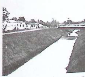
Na primeira foto acima, o trabalho executado na avenida marginal, com a correção do Córrego e a plantação de grama nos barrancos. Na outra foto, máquinas preparam as ruas da avenida para receber o asfalto.
