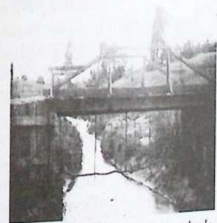
Ponte sobre o Córrego da Estrada do Baixão.
