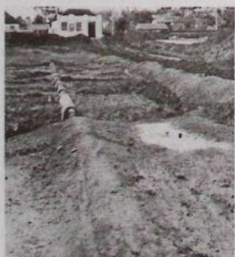
Canalização executada na rede de esgotos para novos emissários, desviando as águas para outro local.
