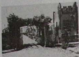
Na reforma do cemitério São José, Paulo Furquim trouxe a entrada principal para a rua Síria.
