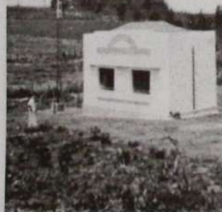
Instalações técnicas na chácara adquirida pela Rádio, da Prefeitura, com 12.000 metros quadrados, onde foram colocados os transmissores funcionando com ondas médias de 187m, ponto 50, com torre vertical de 33 metros de altura, tipo Winchester norte americana, de aço. Essas instalações estão situadas próximo à antiga linha férrea, mais ou menos a 200m da atual Avenida Mário Vieira Marcondes.
