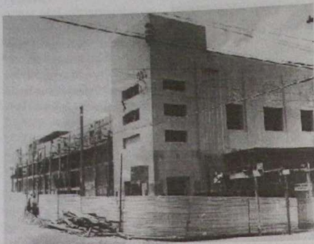
Prédio do Cine Olímpia, adquirido por Domingos Storto nos anos 40, sendo completamente reformado.
