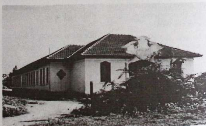
O prédio do Abrigo São José já concluído, em 19/03/51.
