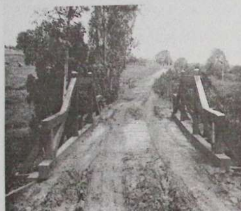
Ponte sobre o Olhos D'Água na rua Benjamin Constant (Rua Boideira). Na parte de cima hoje está a Avenida Constitucionalista.
