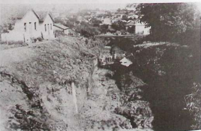
Na foto acima a grande erosão da Rua Floriano Peixoto.
