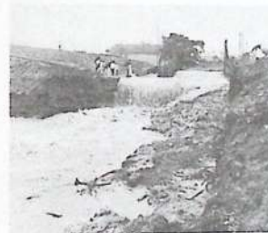
As obras da construção da "Represa do Recco". À esquerda o "ladrão", para escoamento do excesso da água e, à direita, uma visão geral da represa.
