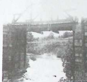
Ponte da estrada Olímpia - Bebedouro, sobre o rio.
