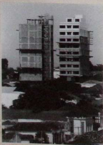
Edifícios Olímpia e 9 de Julho em construção
