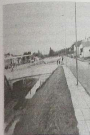
Nova vista panorâmica da Avenida Aurora Forti Neves, já asfaltada.
