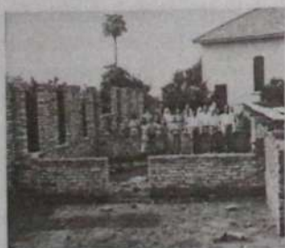
A foto registra as Irmãs de Caridade e velhos abrigados, junto à construção do pavilhão.
