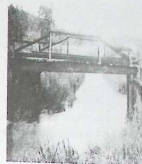
Ponte sobre o Córrego do Capim.
