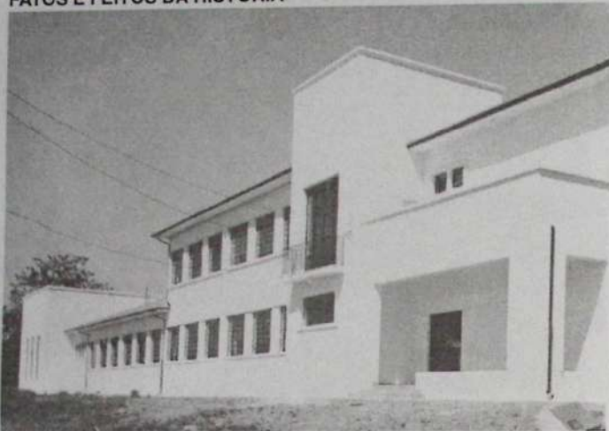
Na foto acima o Ginásio Estadual de Olímpia em fase de construção
