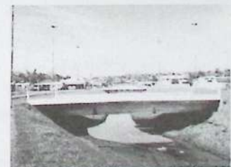
Ponte sobre o Córrego Olhos D'Água, na rua Jorge Tibiriçá.
