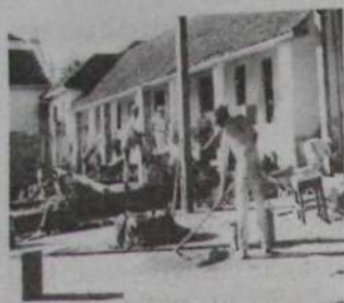
Pedreiros trabalhando na ampliação do Abrigo São José.
