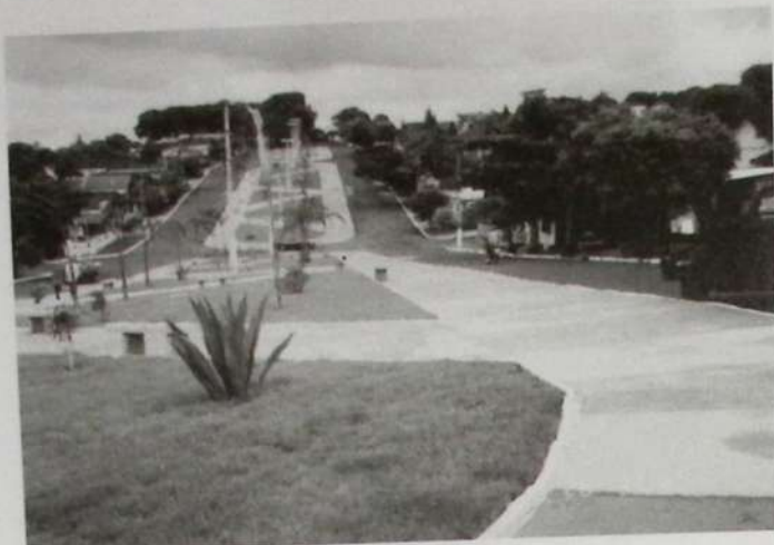
Construção da Praça e remodelação da Avenida Brasil.
