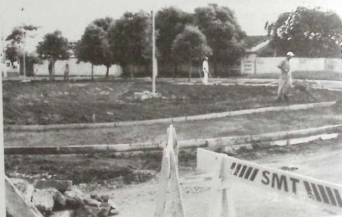
Construção da Praça Menina Moça (Recinto do Folclore).
