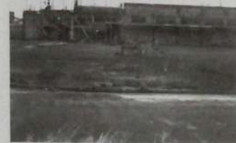
Construção Creche Campo Belo.
