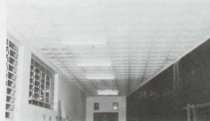
Forro, depois de restaurado, e as paredes envernizadas.
