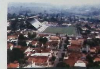
Vista panorâmica, vendo-se ao fundo o Estádio Tereza Breda.
