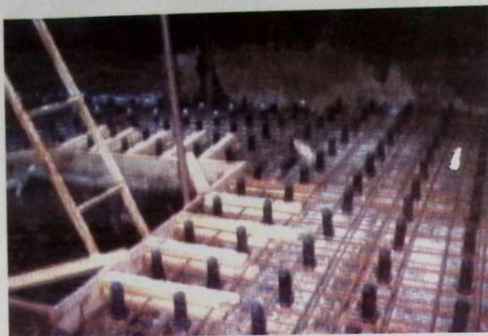
Recuperação total de um dos filtros da Estação de Tratamento de Água, dentro do projeto de ampla reforma do sistema de filtragem da água em nossa cidade.
