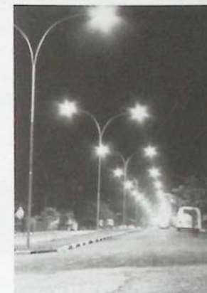
Iluminação da parte central da Avenida Aurora Forti Neves.
