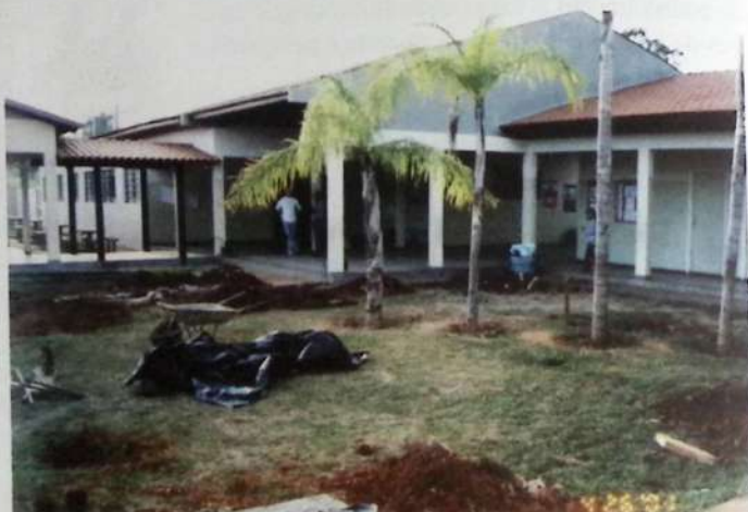
Construção de pátio coberto na EMEIF "Zenaide Rugai Fonseca".
