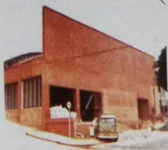
Na foto, o início da construção do prédio da Casa de Cultura, no fim de 1981, na gestão do prefeito Álvaro Marreta Cassiano Ayusso, transformando o antigo Mercado em Casa Cultural.
