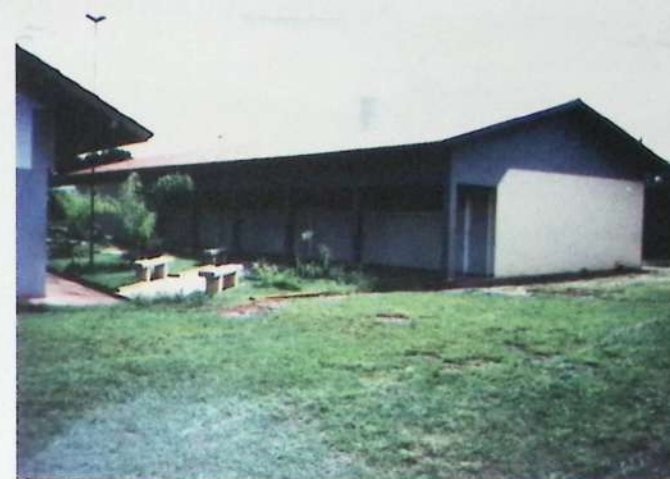
Construção de 3 salas de aula no EMEIF "Alzira Tonelli".
