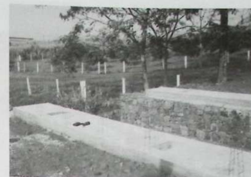
Pontes metálicas sobre os córregos.
