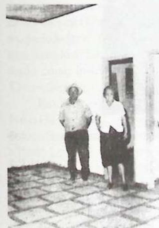
Valentina Toazza e o mestre de obras Fortunato Zanolli inspecionam as obras da nova instituição.
