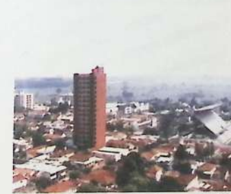
Vista panorâmica, vendo-se o Edifício Eldorado e o TB.
