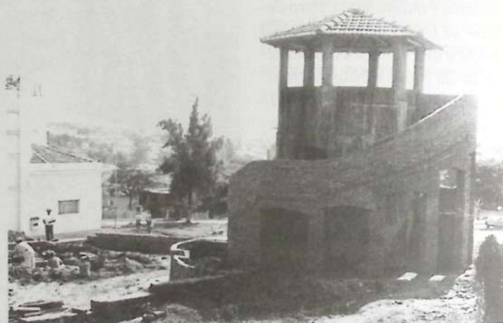
Na foto, um mirante externo, que também era a caixa d'água, que servia aos trens da Estrada de Ferro. Na parte de baixo, nichos dedicados a santos e imagens.
