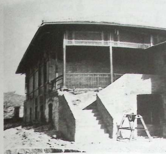
O palacete Tonnan visto pela parte dos fundos em sua reforma.
