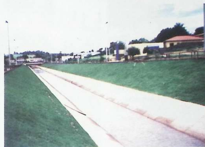
Trecho da Avenida Aurora Forti Neves, onde a prefeitura procedeu a canalização.
