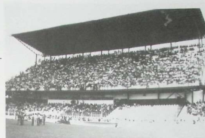
Construção de arquibancadas no Estádio Tereza Breda.
