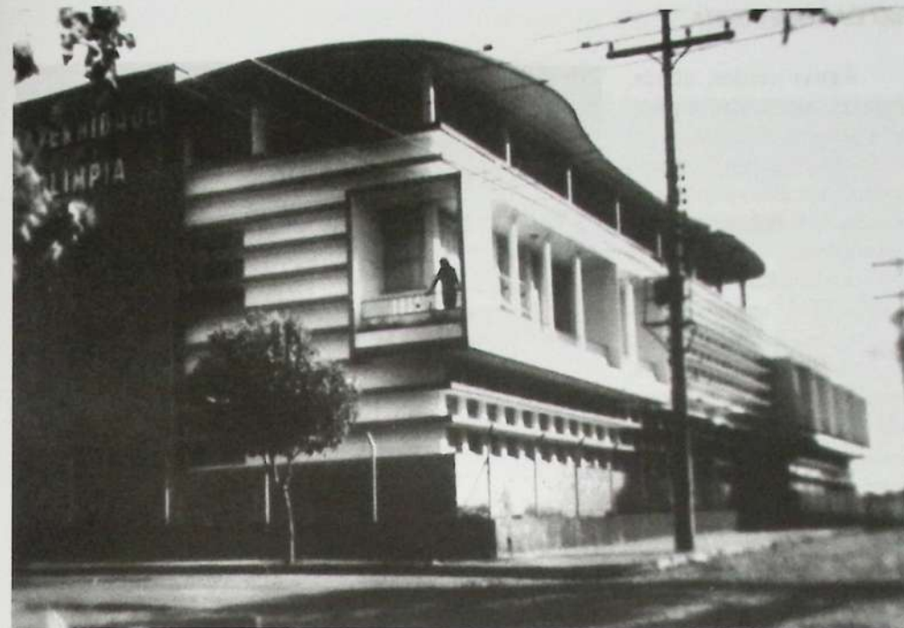
Maternidade de Olímpia, que recebeu uma excepcional contribuição, quarenta e oito milhões de cruzeiros velhos, no programa "Cidade contra Cidade", possibilitando o término das obras.
