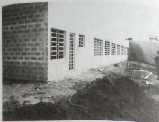
Detalhes das obras de construção da Unidade II (já terminadas) em seu prédio próprio na Avenida Aurora Forti Neves.
