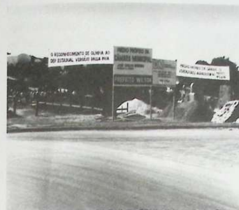
Uma vista das obras do prédio próprio da Câmara Municipal de Olímpia, construído na administração Zangirolami, na Avenida Aurora Forti Neves.
