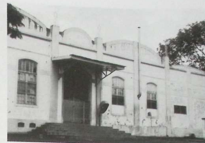
Fachada da Estação de Estrada de Ferro de Olímpia.
