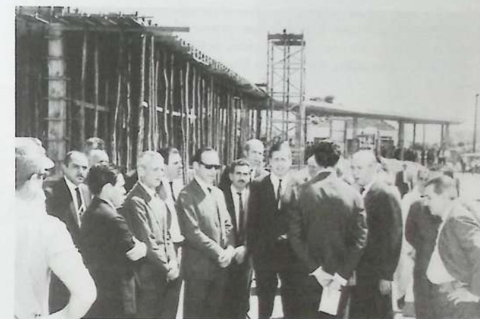
Dr. Alfonso Lopes Ferraz, Deputado Dr. Waldemar Lopes Ferraz e autoridades visitam as obras de construção da estação rodoviária.
