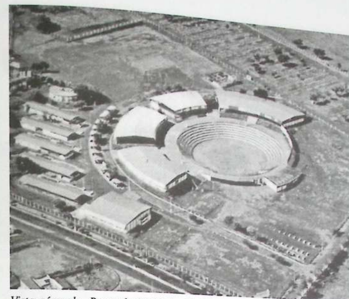
Vista aérea da Praça de Atividades Folclóricas depois de concluída, vê-se a grande arena de apresentações.
