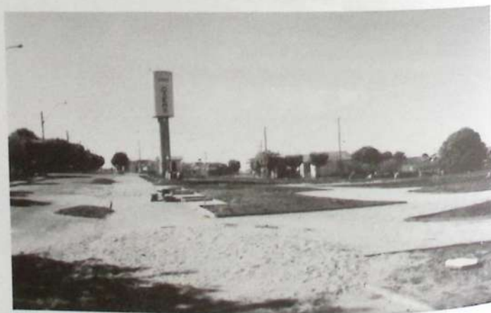
Construção da Praça de Baguaçu.
