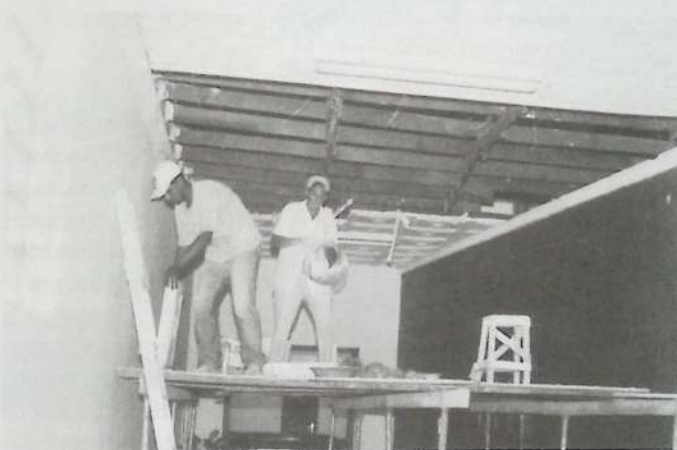
A foto registra o estado em que se encontrava o forro da Casa de Cultura em 1997. Operários trabalham em sua restauração.
