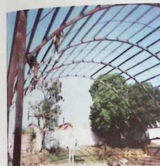
Cobertura da quadra do distrito de Ribeiro dos Santos.
