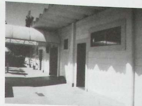
Acima, parte das dependências da FAER, construídas com as especificações adequadas e mais modernas para um ótimo desempenho escolar, recreativo, artístico e social.
