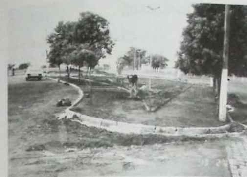
Praça Jardim Menina Moça, em construção.
