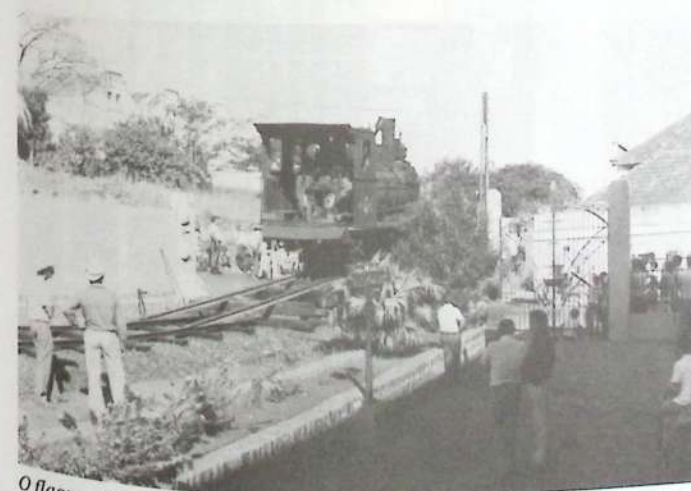
O flagrante mostra a colocação da locomotiva, recebida em doação da FEPASA, no pátio do museu.
