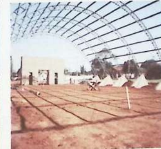
Construção da quadra no distrito de Ribeiro dos Santos.
