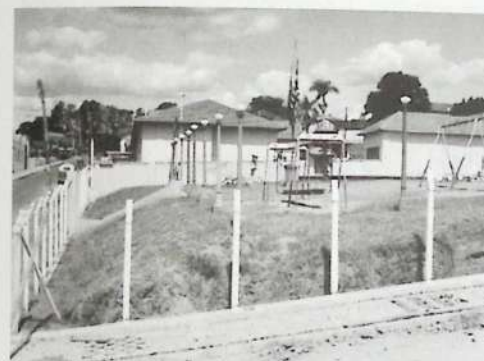
Construção de um parque infantil, anexo ao Instituto de Proteção ao Menor Santa Filomena, para lazer das crianças.
