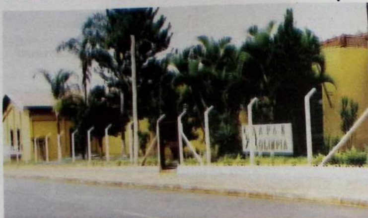
Fachada atual das dependências da APAE, na Avenida de Acesso Dr. Wilquem Manoel Neves.
