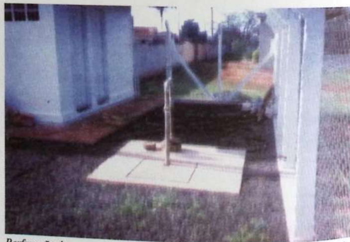
Perfuração de poço e construção da Casa de Quadros com dosadores de cloro/flúor, no distrito de Ribeiro dos Santos.
