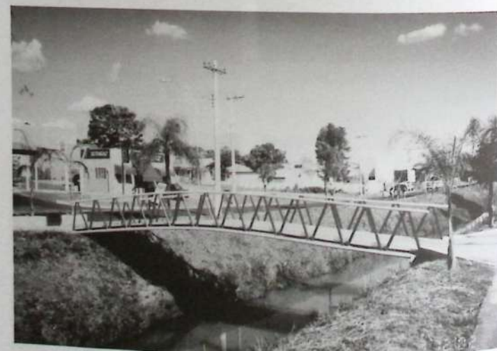
Construção da Passarela sobre o Córrego Olhos d'Água.
