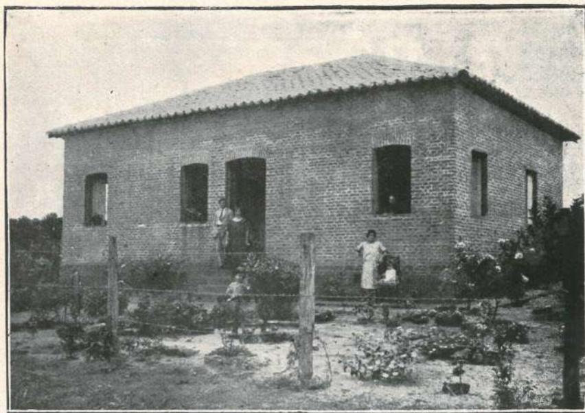
A casa de administração da fazenda, em acabamento,
